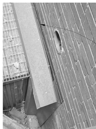
RESET EXISTING COUNTERFLASHING; INSTALL STAINLESS STEEL TERMINATION BAR W/ SEALANT RECEIVER OVER TOP EDGE OF EXISTING COUNTERFLASHING; PROVIDE FASTENERS @ MAX. 8\"/>
